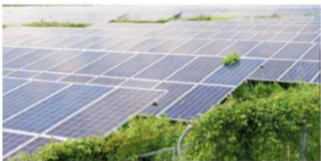
太陽光発電設置
