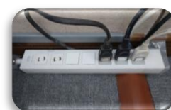
コンセントの点検管理
