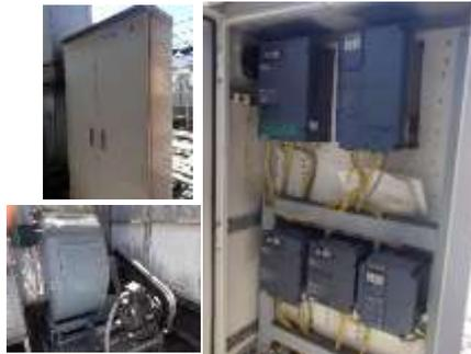
吸排気ファンモーターをインバーターにて制御駆動電流の削減
