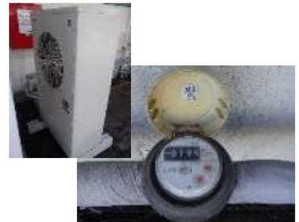
機器の水道メーターを取付け使用量の日々のチェックと漏水の早期発見による水使用量の削減
