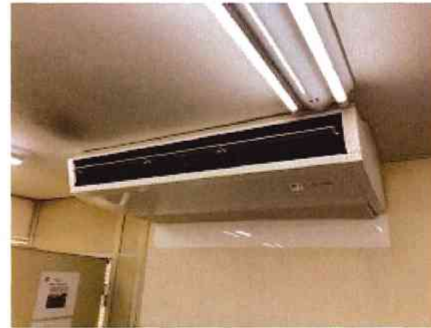
空調設備更新
