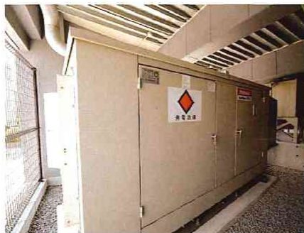
非常用発電機の設置
