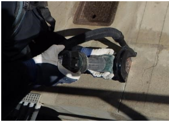
<環境配慮の施工：集塵機付カッター使用>
