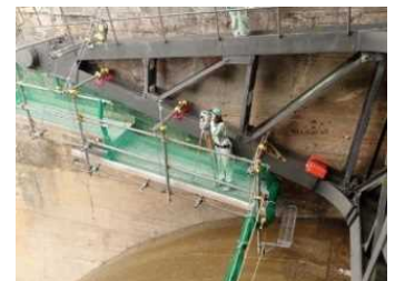
洪水吐ゲート点検
