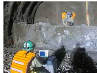
FDEMによるトンネル切羽前方探査
