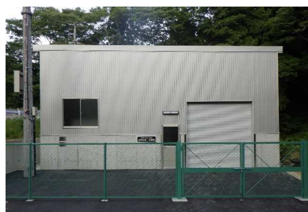
上松駒ヶ岳発電所
