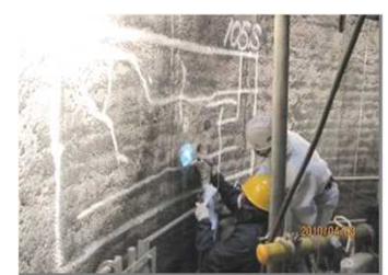
煙突の内部点検
