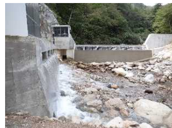
小水力発電所の建設
