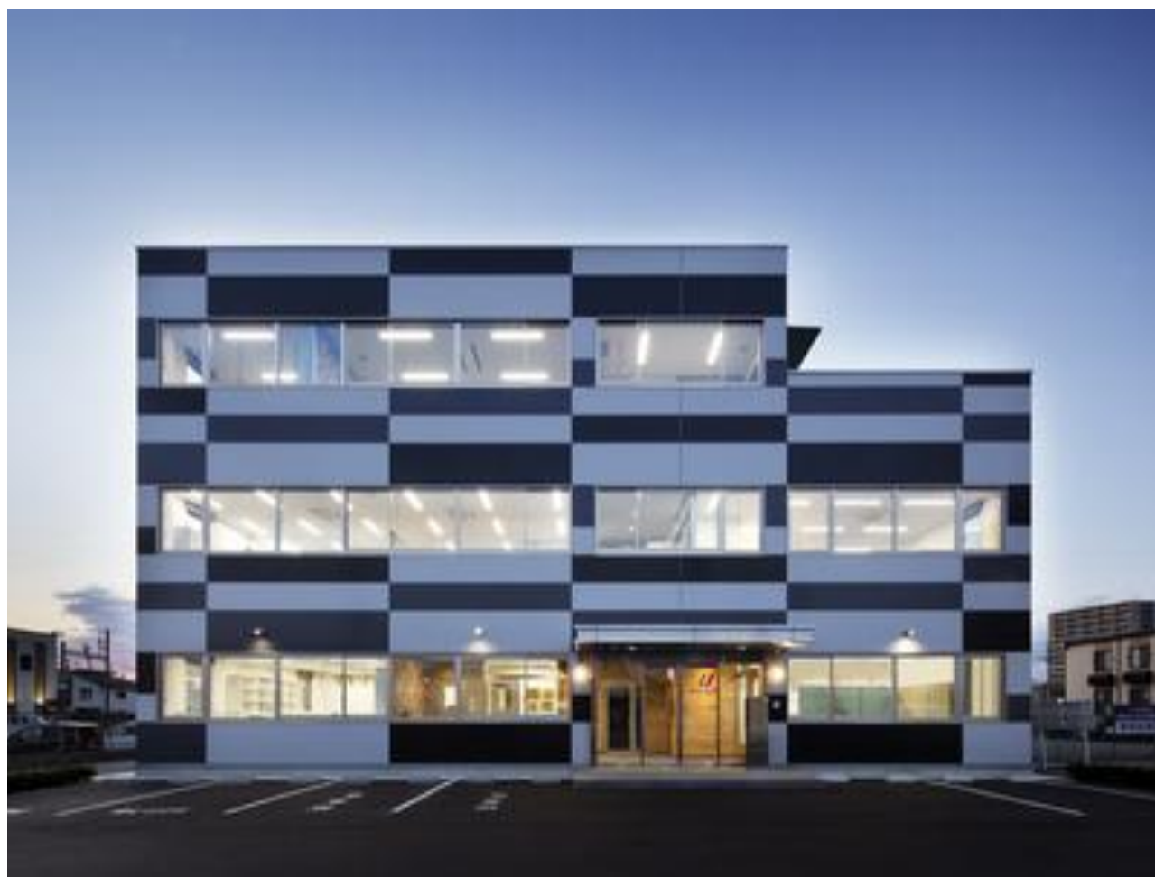
1 階部分岡崎建設㈱本社
