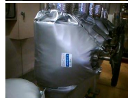
エコジャケットによる断熱効果
