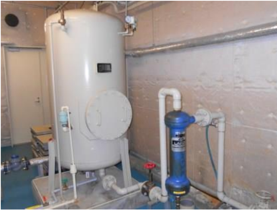
IIF三鷹カードセンターの自動給水装置
