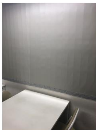
遮熱フィルムで遮断しています
