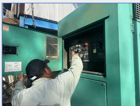
発電機メンテナンスの様子
