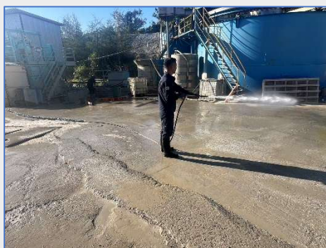
敷地内での散水
