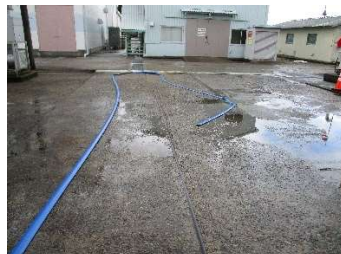
2工場北側の様子
