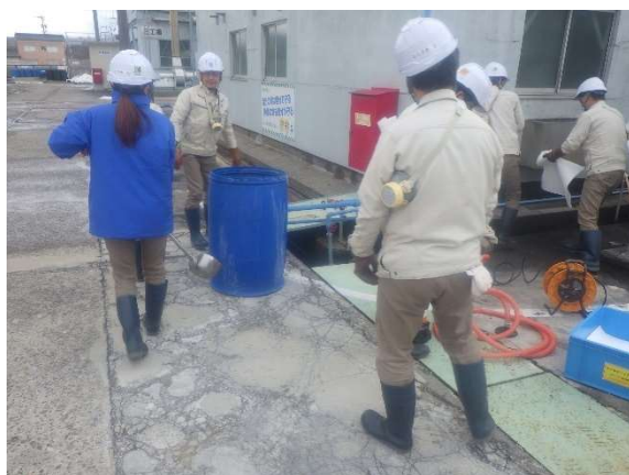
汚染水をポンプや柄杓で汲み上げている様子
