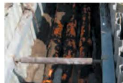
配管まわりの埋戻し
