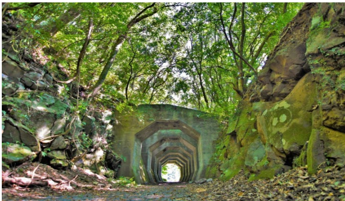
美里町八角トンネル
