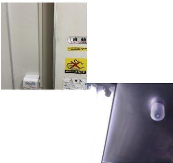
人感センサー3か所追加、ドア開放防止のため、手動ドアを自動ドアに1か所変更し節電に取組みました。
