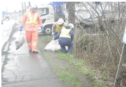
解体工事現場周辺の清掃活動
