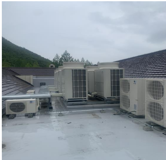
<環境配慮の施工>
