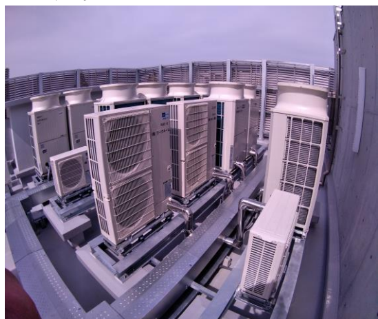
<環境配慮の施工>
