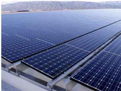
太陽光発電システムを設置(発電容量は最大151kw/h)
