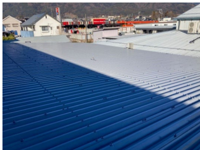
宮田工場大屋根の断熱塗装実施
