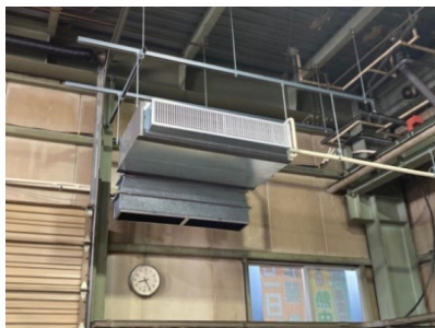
宮田工場の空調機を最新型に更新
