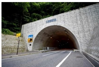
城山・塩谷トンネル内照明 等 電気設備工事 (兵庫県但馬県民局)
