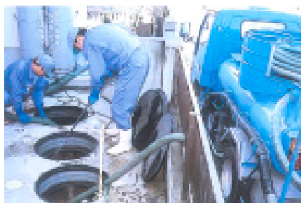
浄化槽の清掃
