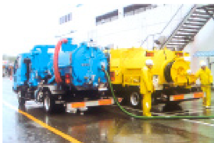
下水管の清掃(排水管洗浄)
