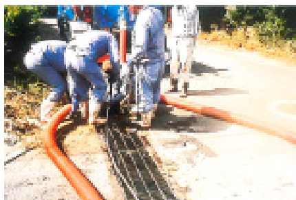
排水溝の清掃
