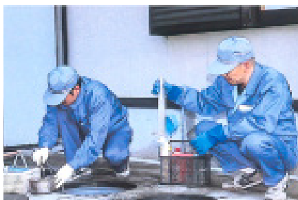
浄化槽の保守点検 維持管理
