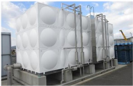
受水槽の遮熱塗装
