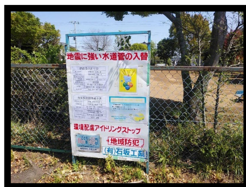
環境啓発の工事看板
