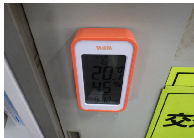
温度計設置で温度管理
