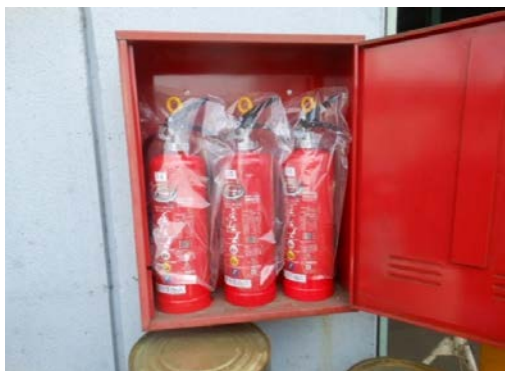
＜ 消火器 新品に交換設置 ＞ 2020年 7月
