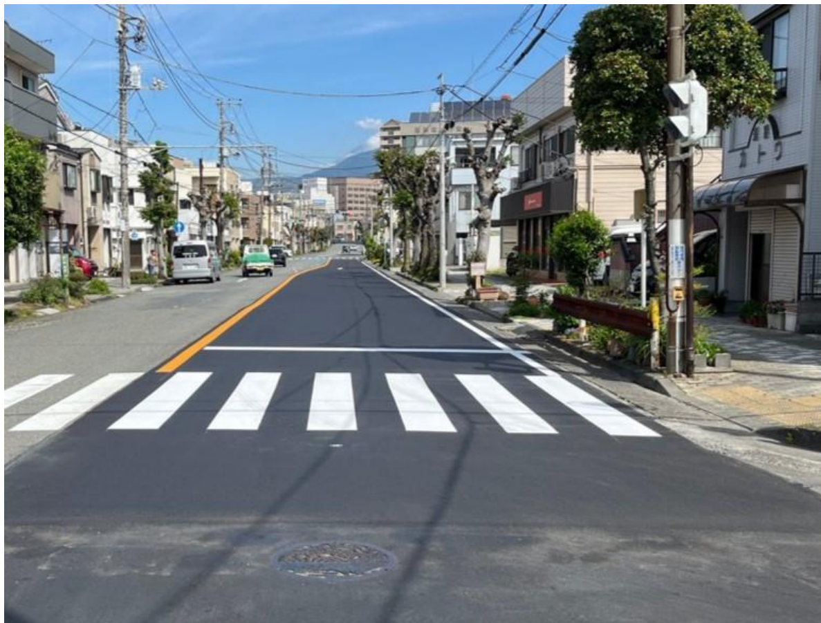
吉田町地内管渠布設工事
