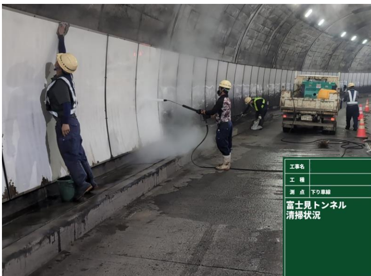
【トンネル内清掃】
