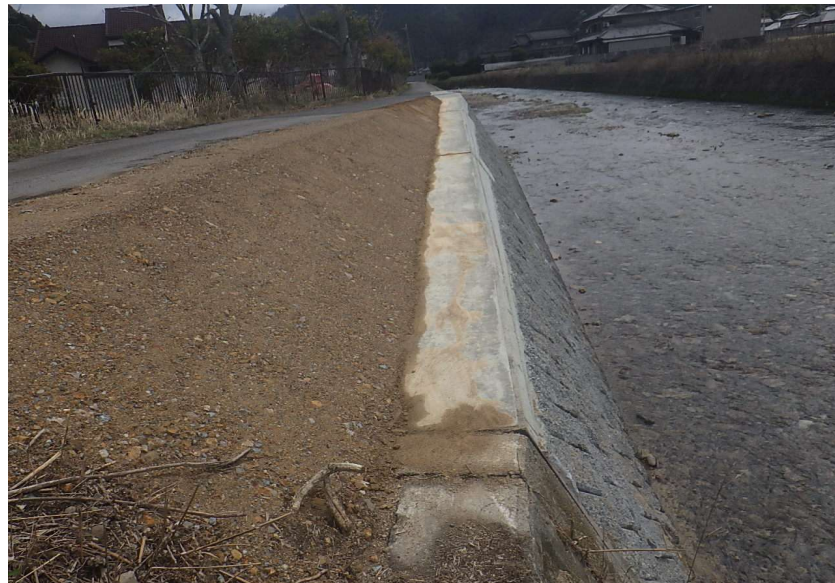
加古川水系野間川護岸修繕工事 (令和5年度工事)
