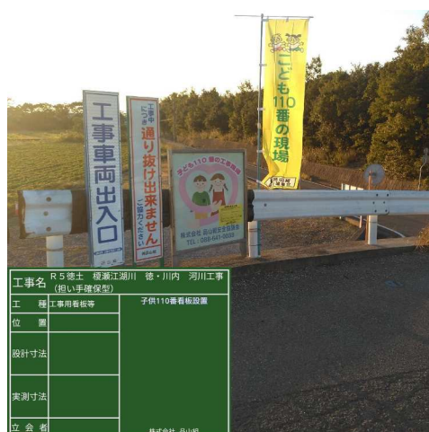
現場での活動（幟、看板設置）
