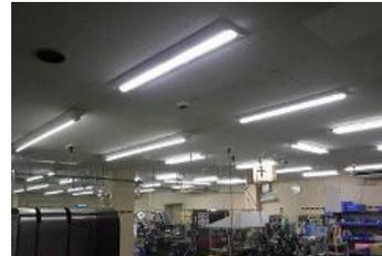
製造現場・および事務所LED照明LED照明器具に交換(389本交換)
