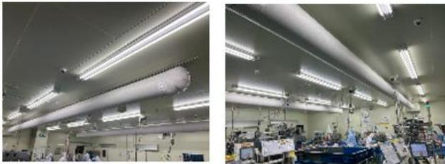
1F洋菓子包装室 2F和菓子包装室LED照明LED照明器具に交換(96本交換)
