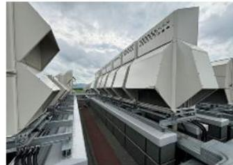
室外機に対し、散水設備の設置夏場温度上昇を抑え、節電に努める
