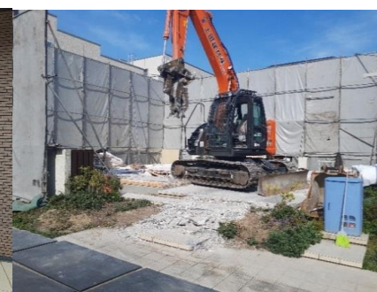
モデルハウス基礎撤去中
