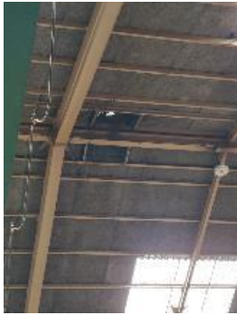
工場全体換気装置
