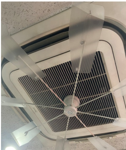
空調効率対策 シーリングファン設置
