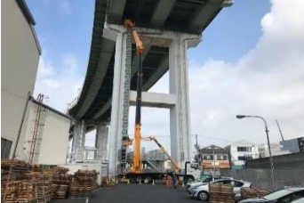
②阪神高速道路 変電塔設備補修工事
