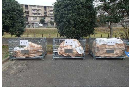
工事現場 産業廃棄物保管場所
