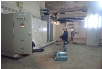
①津守下水処理場 監視制御設備外機能追加工 事
