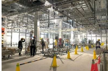
④加賀東芝 電気設備工事
