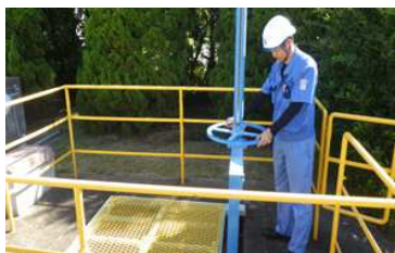
水門 開閉手順確認
