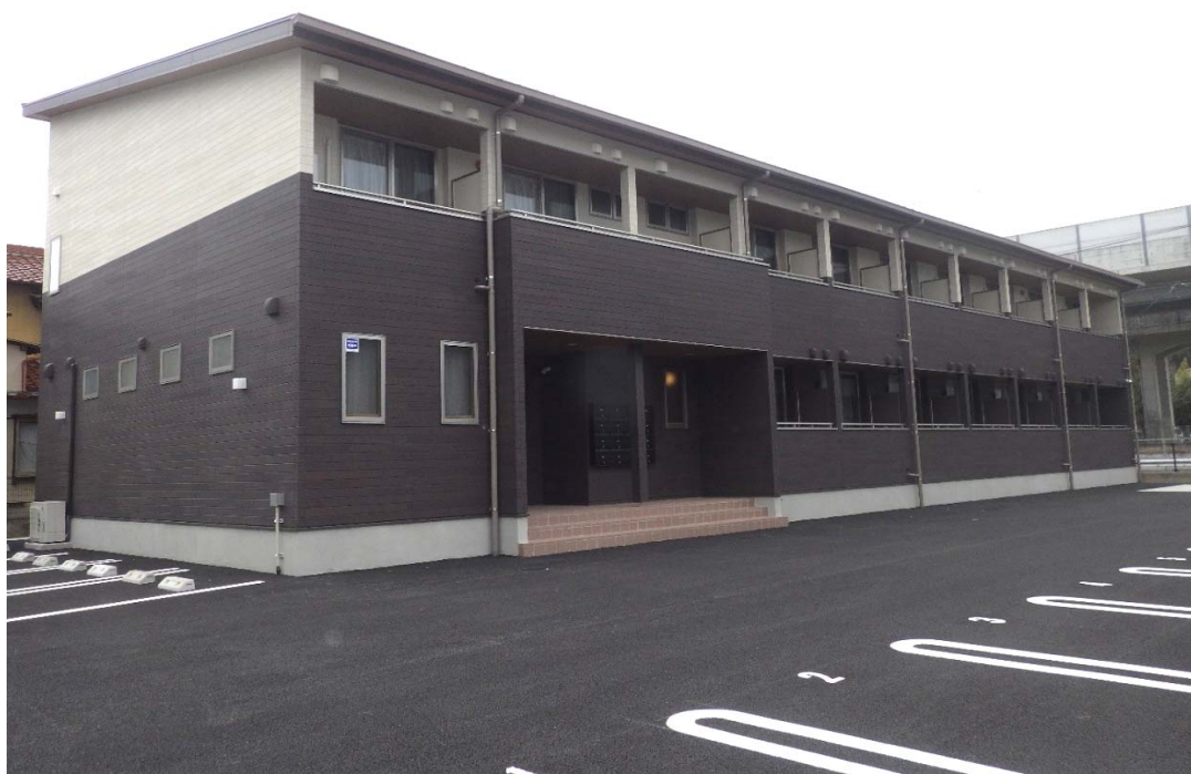
当社の施工事例
