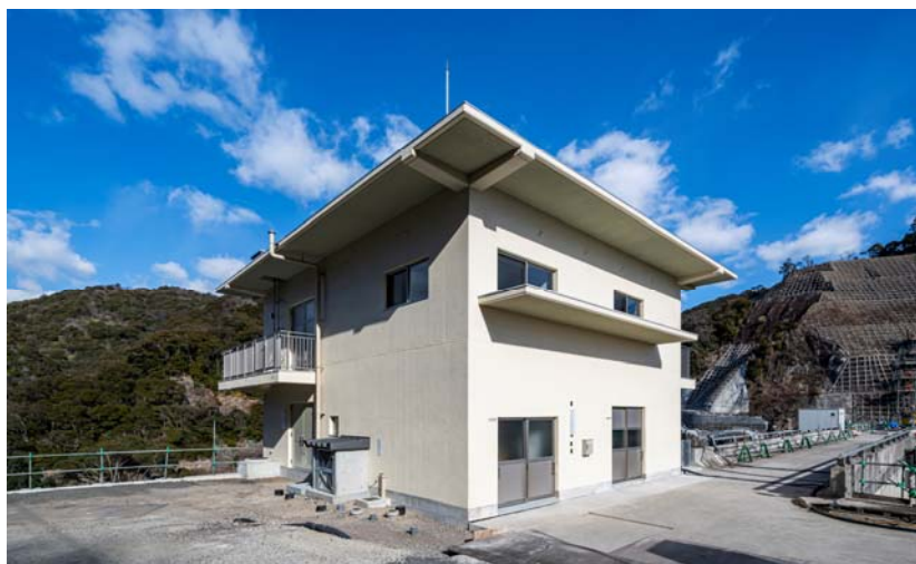
和食ダム管理棟等建築主体工事
