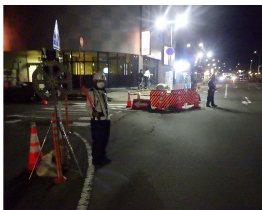
夜間工事警備誘導
