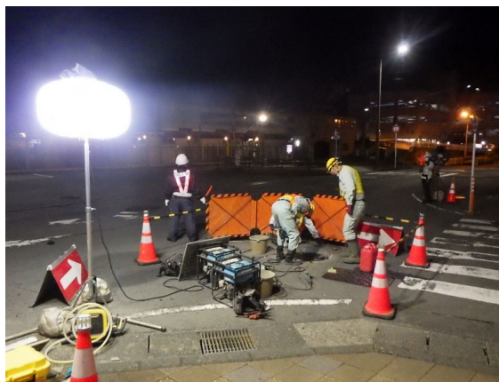
マンホール蓋交換工事 （日中の交通量が多い為夜間工事を実施）
