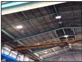
LED照明照度調整済 (タイマー設定)
