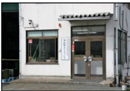
↑ 事務所電源に活用
