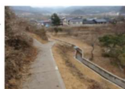
寄宮地区集落内排水路整備工事
