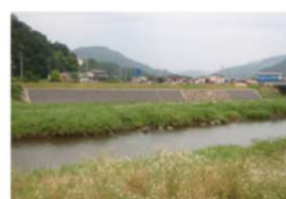
(一)円山川水系八木川護岸整備工事
