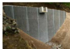
林道大ナル線災害復旧工事
