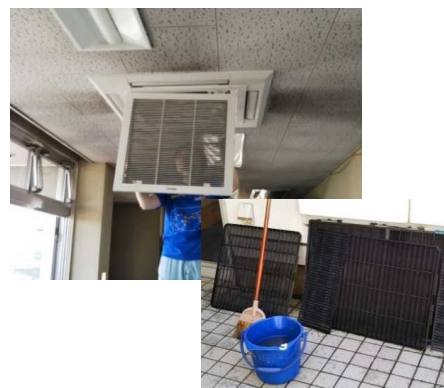
エアコンフィルター清掃 8月
