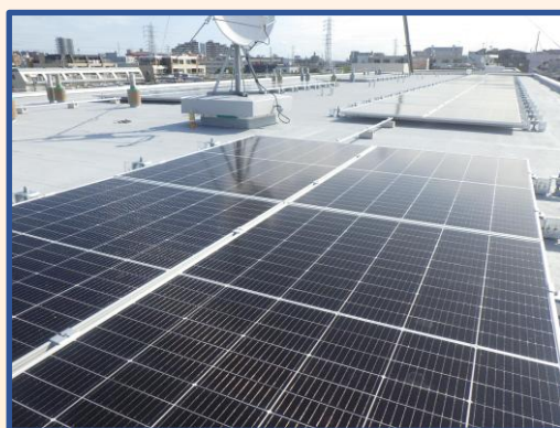
太陽光発電設備設置
