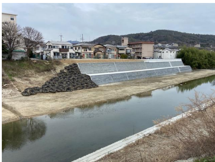
淀川水系猪名川 護岸工事 (左岸第11工区)
