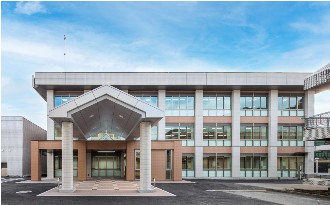
2022年度施工：長南町役場庁舎建設工事
