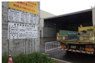
アスファルトガラの処理
