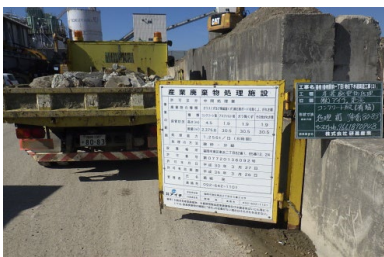
コンクリートガラの処理
