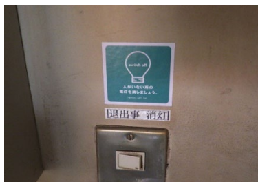
照明節電ステッカーの貼り付け
