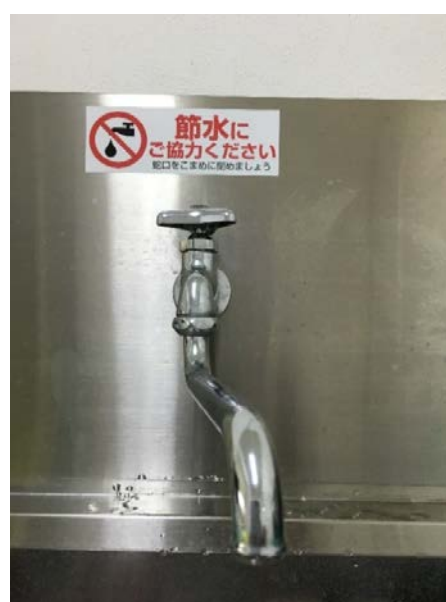
節水ステッカー貼付 (平成28年6月設置)
