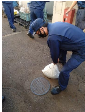
オイル吸着材の設置確認
