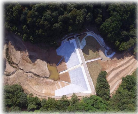
柏池堤体工事
