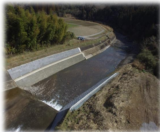
恵良川災害復旧工事
