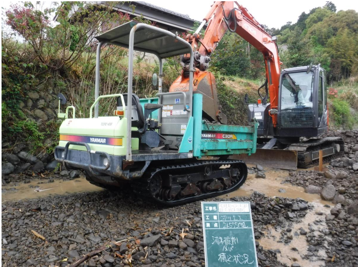
( 塩田川浚渫工事の様子↑ )
