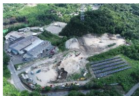
蓮池改良土センター
