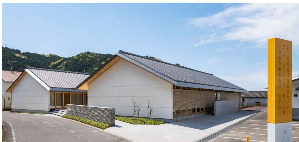
高知県安芸郡北川村「小規模多機能施設 ゆずの花」：自社施工
