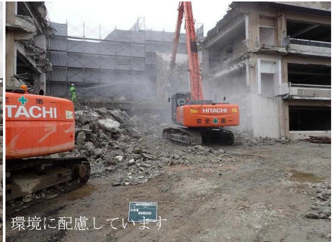
低騒音重機を使用し
